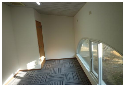
10月 旧イサク湯更衣室改修工事
