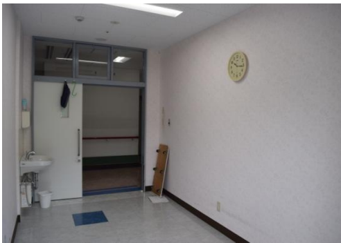
6月 3階個室化工事
