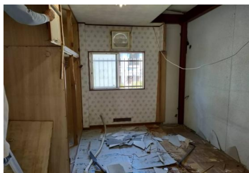
10月 まりあ保育園宿舎改装工事
